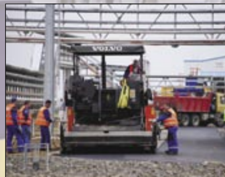
Asfaltovanie v areáli kompresorovej stanice trvalo štyri dni.
