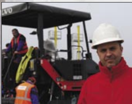
Manažér projektu Martin Nemjo preplával náročnými skúškami stavby so ctou. Vozu časť asfaltárskej čaty závodu 03.
