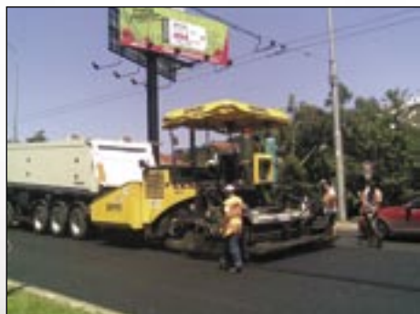
Pokládka obrusnej vrstvy na Pražskej ulici v Bratislave.
