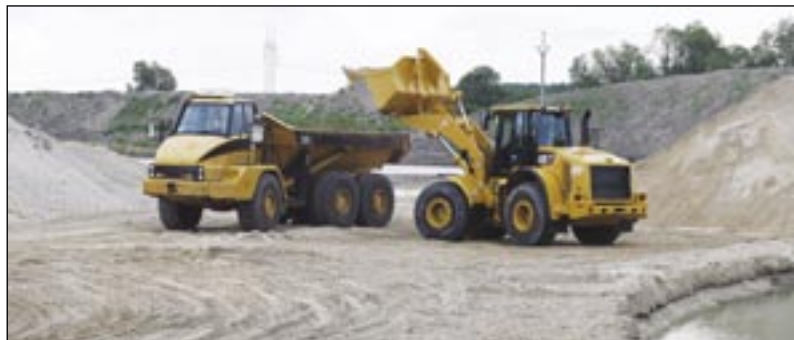
Linka v prevádzke: materiál do dumpera
