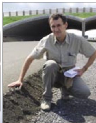
Vrstva mechanicky spevneného kameniva pri ekodukte.
