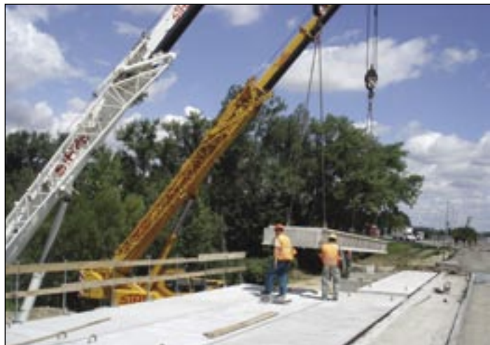
Osádzanie prefabrikovaných nosníkov na moste 057 pri odpočívadle Zeleneč.
