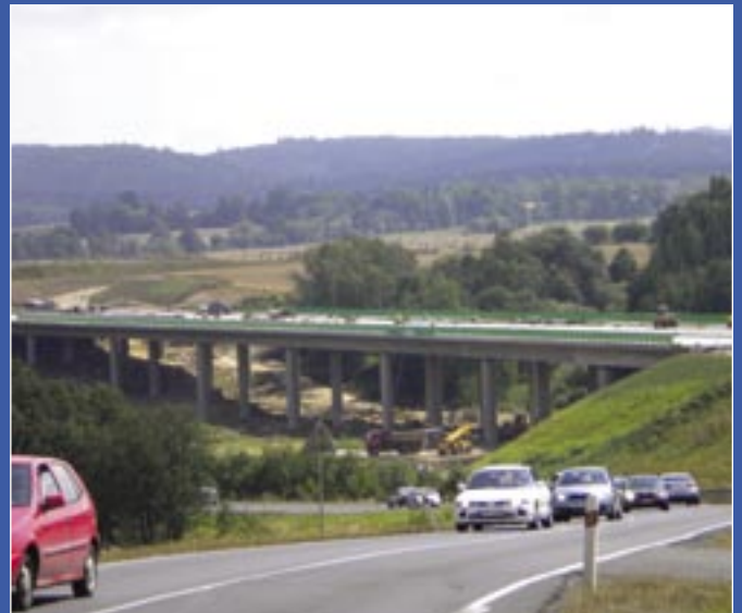
Největší pýcha firmy SANGREEN – most SO 201 na silnici R6.
