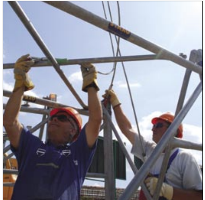
Pracovníci František Hanušovský (v modrom) a Milan Macej skladajú tzv. staxa veže k pilierom mosta 212.
