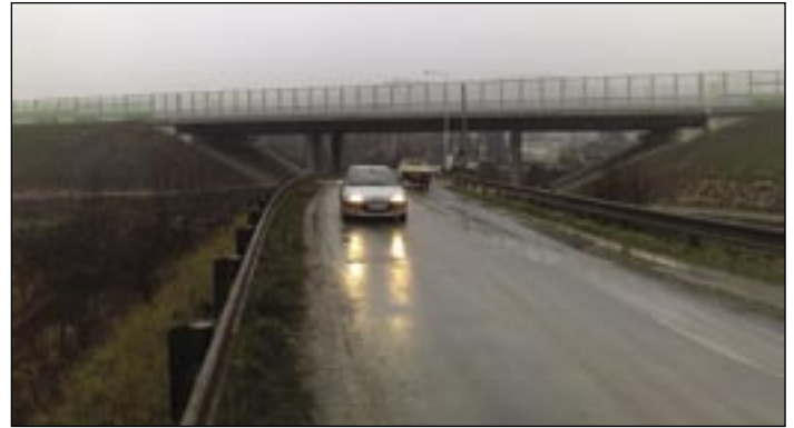
Hotový most aj s časťou protihlukovej steny.
