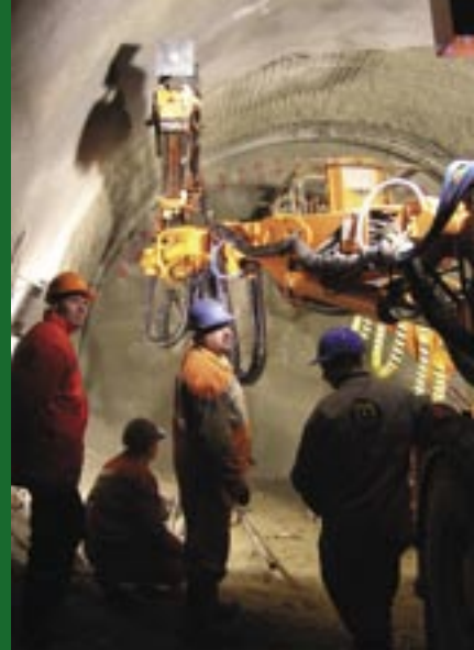
Vrtanie ochranného dáždnika v pilierovej štôlni na západnom portáli.
