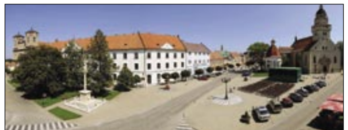
Ukážková rekonštrukcia historického jadra Skalice sa stala výstavným kusom fortela CIEST NITRA. Fotografia sa nachádza aj v kalendári COLAS-u na rok 2010.
