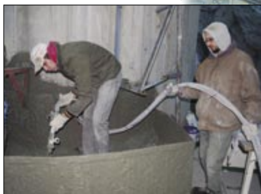
Úprava vodopádu nástrekom plastovej vrstvy.
