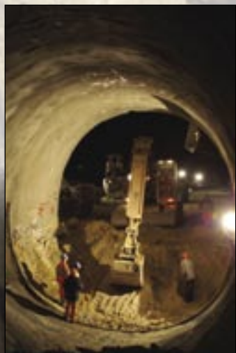
Razenie spodnej klenby pilierovej štôlne od západného portálu.
