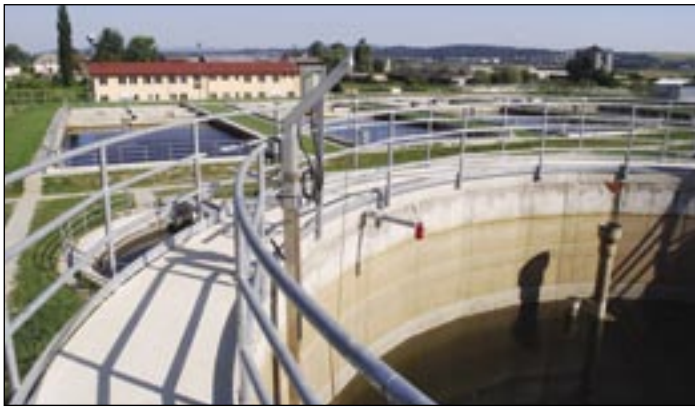
Najväčším srdcom stavby je čistiareň odpadových vôd vo Vranove-Lomnici.
