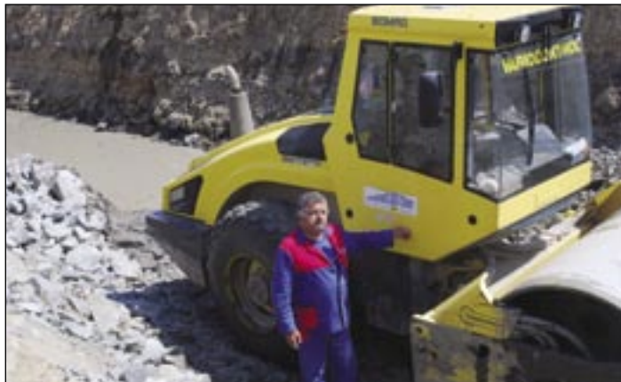
Július Bók zo závodu 03 vypomáha so svojim valcom. Spevňuje dno výkopu pre oporný múr. Výkop bol ešte v máji plný vody.
