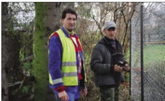
Rastislav Petra (vpravo) a Ladislav Urban zo závodu 03 pracovali v novembri aj na provizórnom oplotení v blízkosti demolovaného domu.
