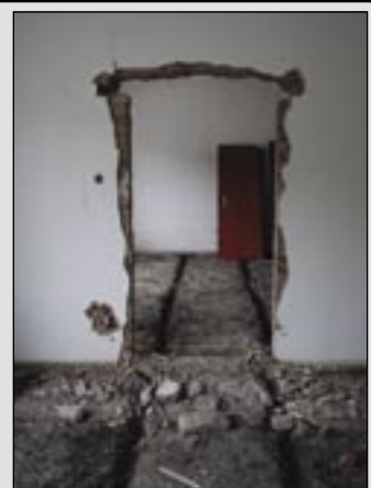
Takto to vyzerá v dome pred demoláciou.
