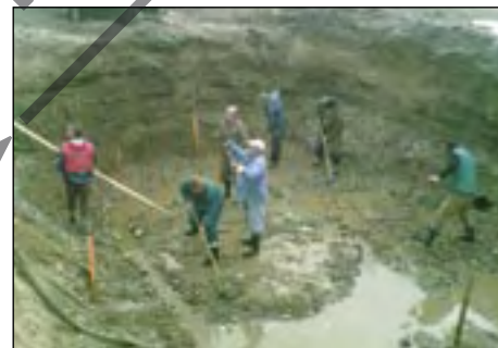
Výkop jamy pre odlučovač ropných látok si vyžadoval nasadenie a súhru.
