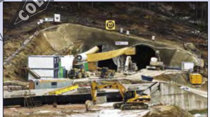
Stavba tunela Bôrik v režii konzorcia IS - Marti.
